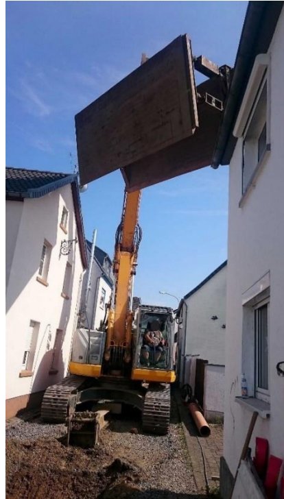
Quelle: AW Bad Honnef; Kanalbau Schulstr.
