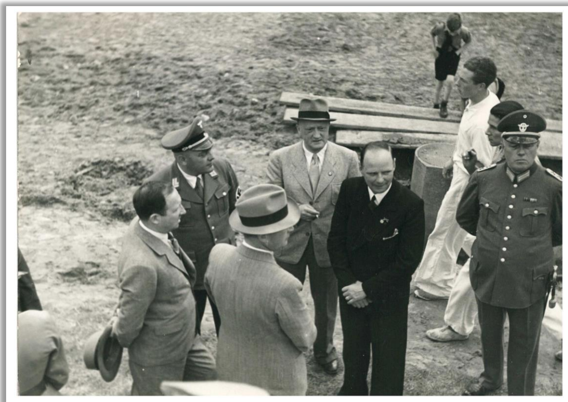
Bürgermeister Schloemer (im schwarzen Anzug) auf der Baustelle des Thermalbades auf der Insel Grafenwerth mit weiteren Parteimitgliedern (Stadtarchiv Bad Honnef)
