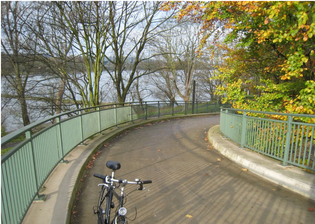
Abb. 35: Zugangsrampen und Brückenbauwerke über die B42 © RMP, 2015
