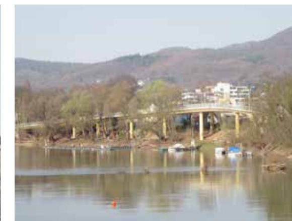
Abb. 39: Brücke Lohfelder Straße
