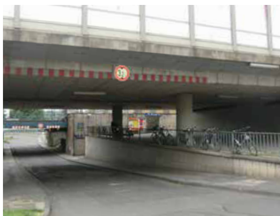
Abb. 40: Unterführung am Bahnhof Rhöndorf
