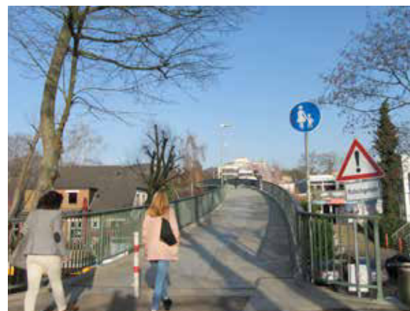
Abb. 59: Brücke an der Stadtbahn-Endhaltestelle
