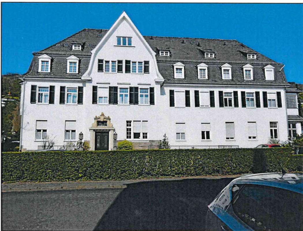
Abbildung 8: Haus Rheinfrieden / Südwestseite
