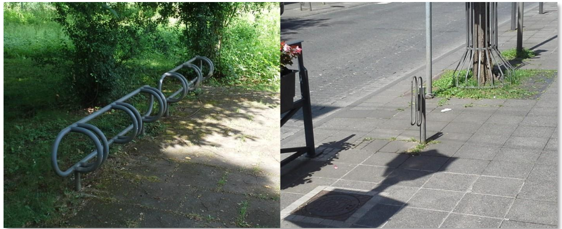
Abbildung 8: Beispiele für nicht anforderungsgerechte Vorderradhalter am Rheinradweg (links) und an der Hauptstraße (rechts) in Bad Honnef
